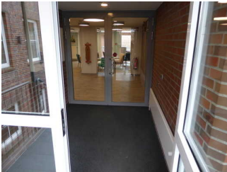
geöffnete Eingangstür nach Treppe
