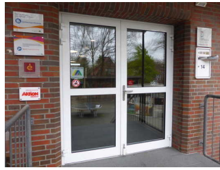
Eingangstür nach Treppe
