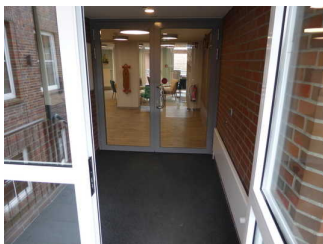
geöffnete Eingangstür nach Treppe
