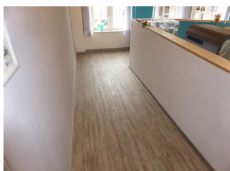
Rampe nach Zugang
