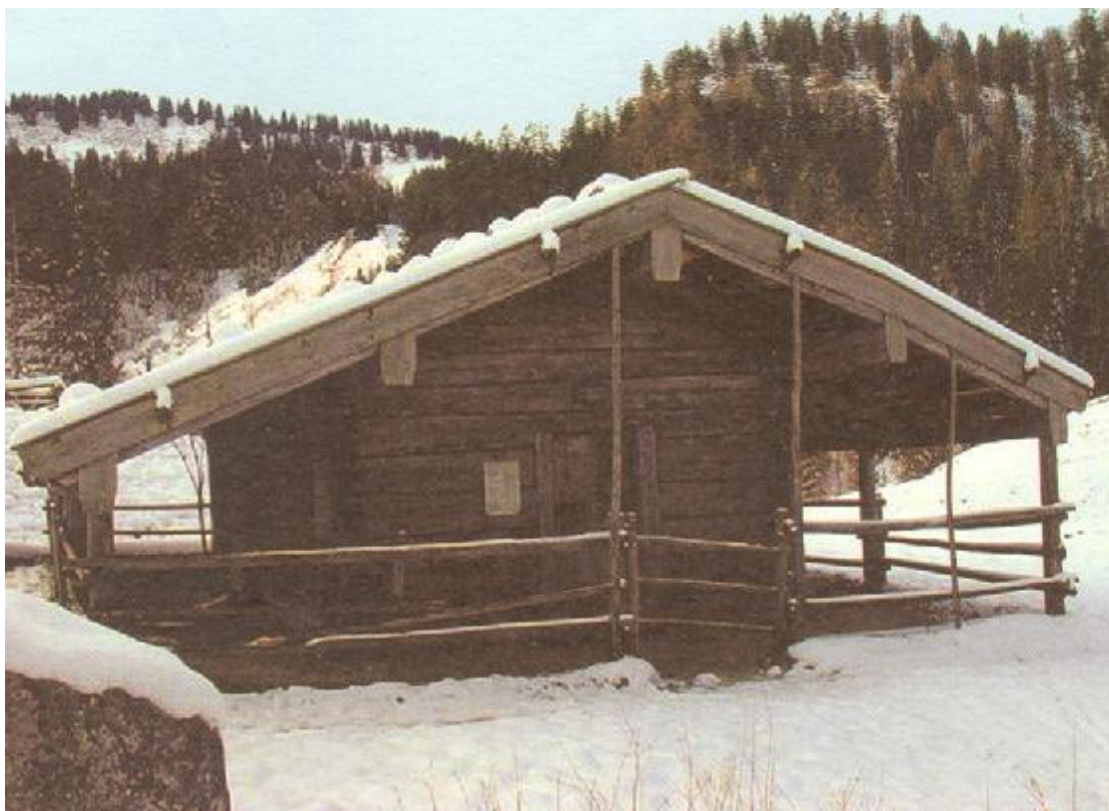
Hüttln mit vorgezogenem Dach und Stangengerüst
